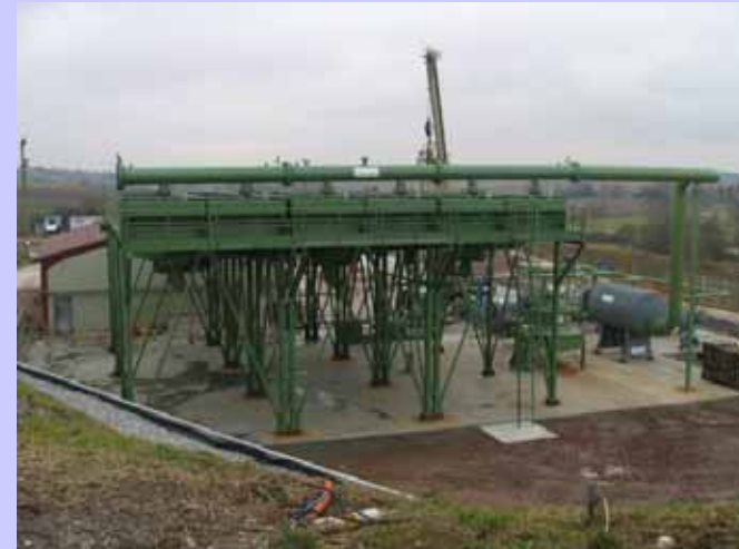
Le GEIE de Sultz-sous-Forêts : un site géothermique soumis au Code minier (photo : l'unité de production électrique en cours d'assemblage)
