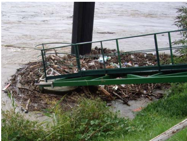
Objets flottants autour du détecteur d'hydrocarbures
