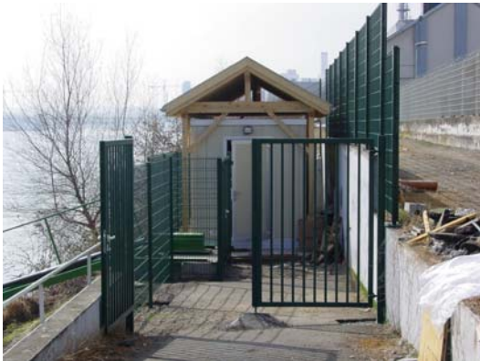
Station : vue générale
