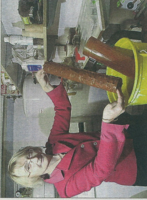
Claire Mentzler montre le filtre d'une pompe à chaleur colmatée par des dépôts de fer. Photo Jean-Marc Loos
