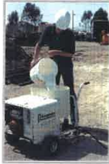
Le coulis ORC est versé dans une pompe d'injection
