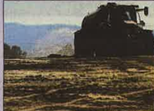
Sur le chantier du GCO, des milliers de litres d'eau sont utilisés, notamment pour arroser les pistes et éviter la dispersion de poussières.
