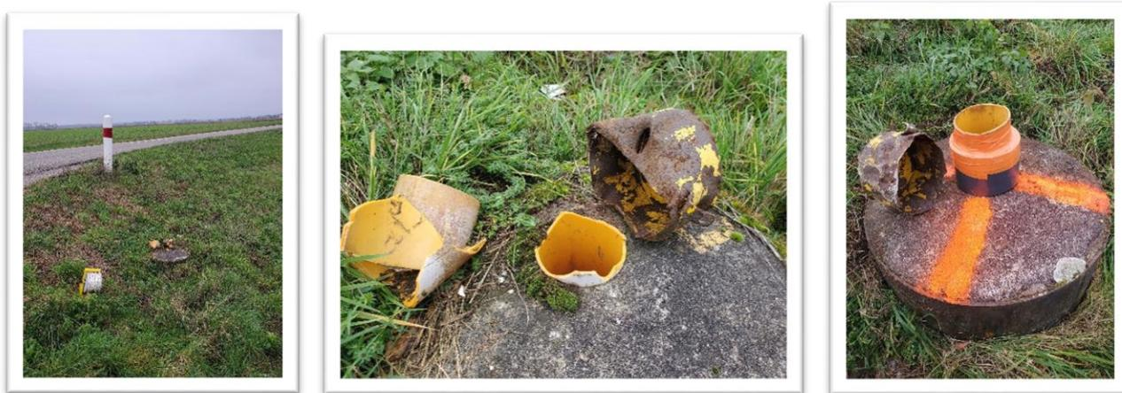
*Piezomètre abîmé par une débroussailleuse à Hoerd*
