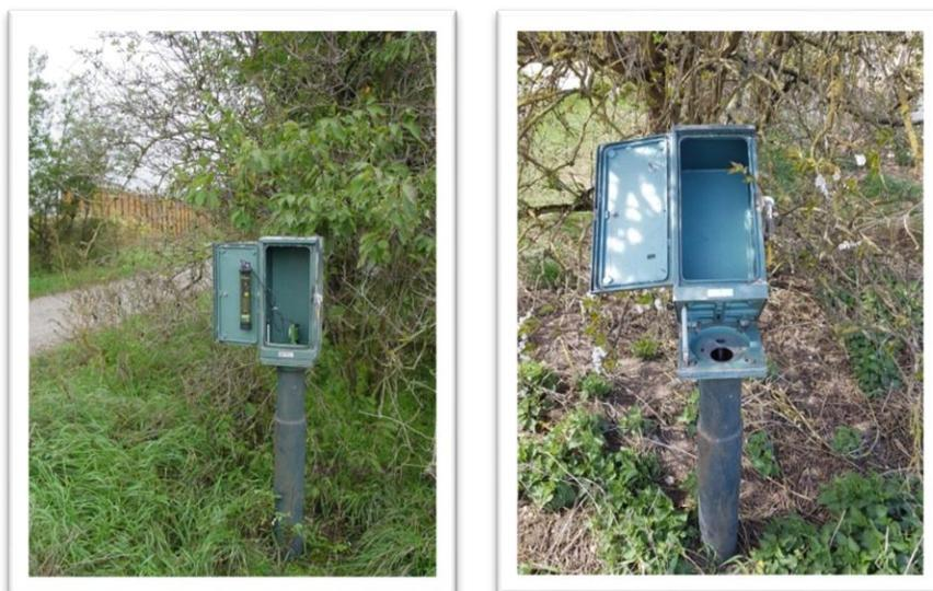
Centrale OTT Thalimèdes (roue codeuse) remplacée par centrale OTT Orphéus-mini (mesure niveau + température) dans boîtier historique (anciennement piézographe) - Oberentzen
