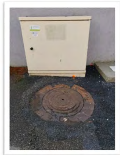
Boîtier abritant la centrale télétransmise et situé à l'arrière du puits (point RCS) à Hettenschlag
