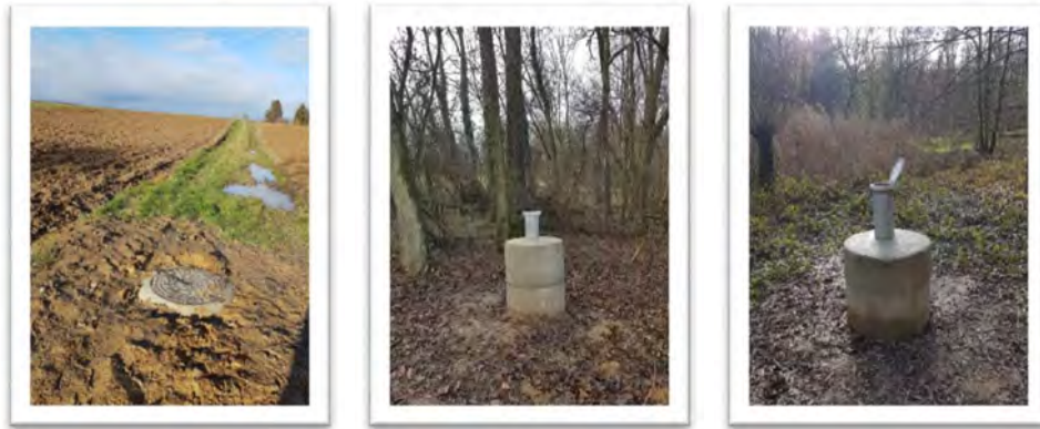
6 piézomètres réalisés (2018) et équipés depuis 2019 pour le suivi du secteur du Kabis
