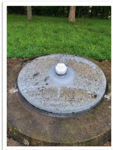
Etat après travaux évitant l'intervention en binôme à Griesheim-près-Molsheim
