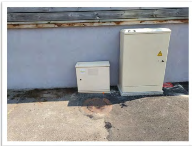
Boîtier abritant la centrale télétransmise et situé à l'arrière du puits (point RCS) à Hettenschlag
