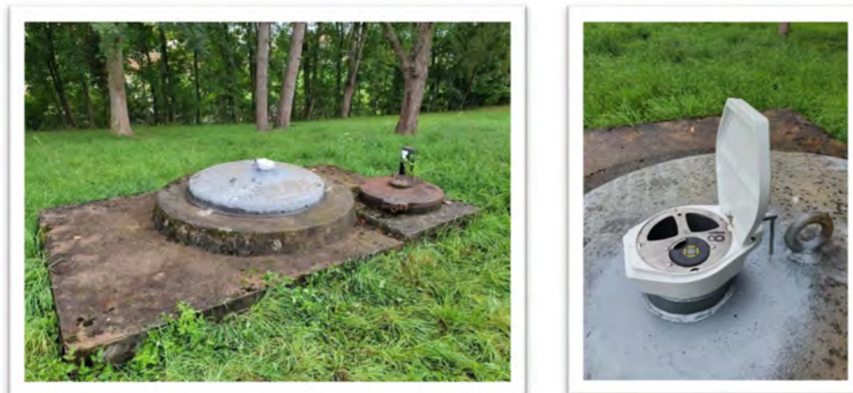
Nouveau forage sécurisé du point RCS à Habsheim
