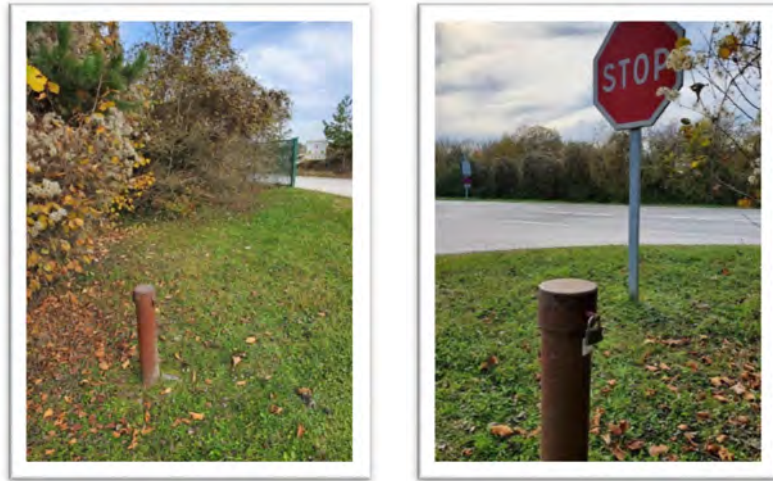
Centrale télétransmise dans le tubage avec fermeture sécurisée à Lauterbourg
