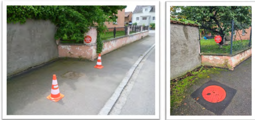
Etat avant et après travaux fermeture couvercle à Jepsheim
