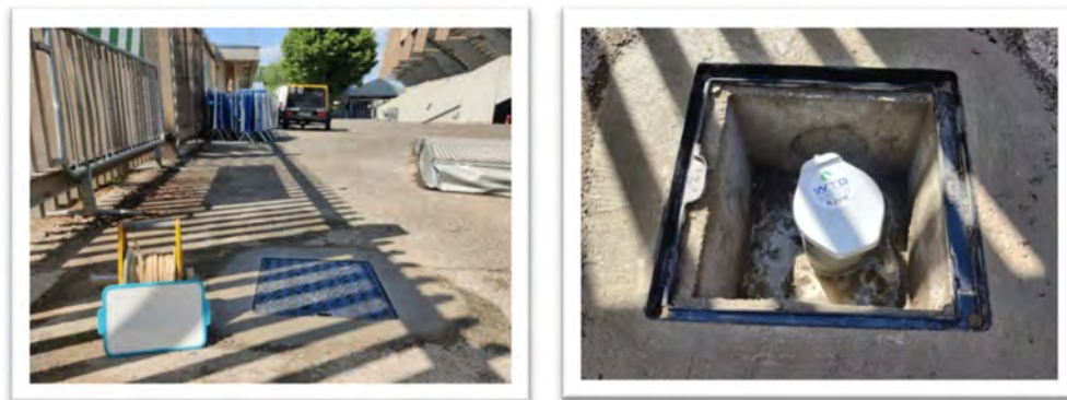
Ancien ouvrage arrêté et nouveau piézomètre équipé à Strasbourg - la Meinau
