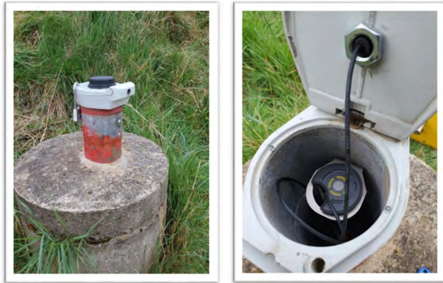
Travaux pour équiper et sécuriser le piézomètre avec une centrale télétransmise à Offendorf
