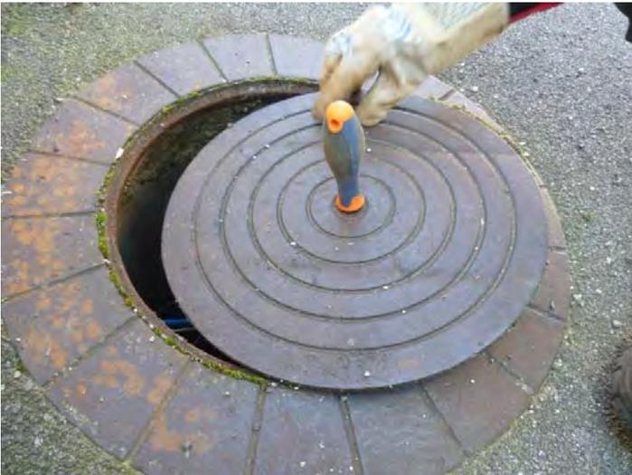
Tirer le couvercle vers soi en veillant à ce qu'il reste sur le puits en couvrant les  $\frac{3}{4}$  de l'ouverture afin de respecter les prescriptions de la **PROCEDURE SECURITE PIEZOMETRE HETTENSCHLAG**.
