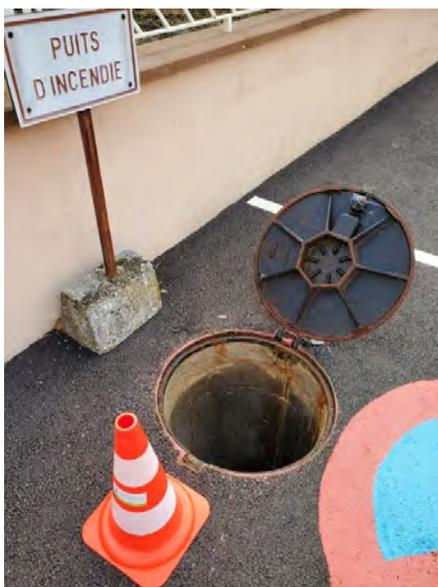
Basculer le couvercle en position ouverte au-delà de la verticale jusqu'à la butée et protéger l'ouverture du puits en plaçant le crochet en travers ou en signalant l'ouverture avec un cône afin de respecter les prescriptions de la **PROCEDURE SECURITE PIEZOMETRE ROSSFELD.**
