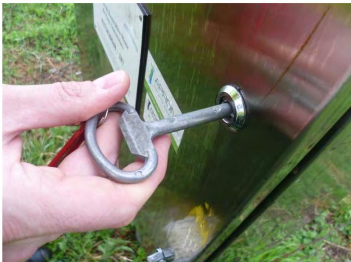
Insérer la clé spéciale boîtier AERM et déverrouiller la serrure.
