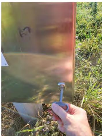
Insérer la clé spéciale boitier AERM et déverrouiller la serrure.
