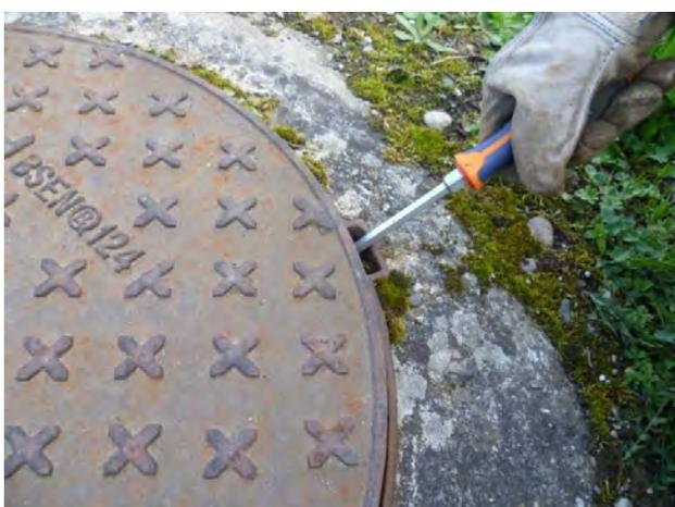
Ouvrir le couvercle du puits à l'aide du tournevis à tête plate.
