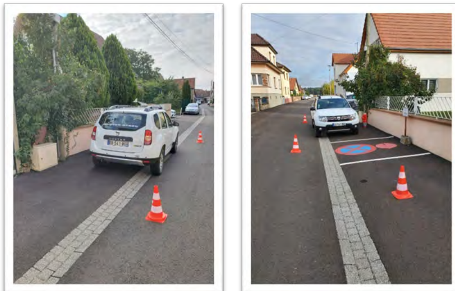
Positionnement de 3 cônes de signalisation + véhicule autour du puits lors du relevé de mesures à Rossfeld
