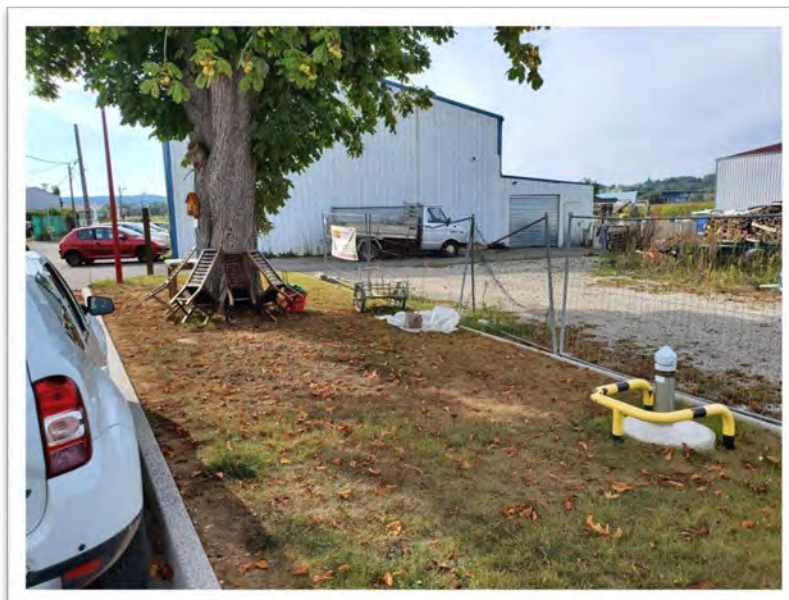
Etat final du nouveau forage à Habsheim
