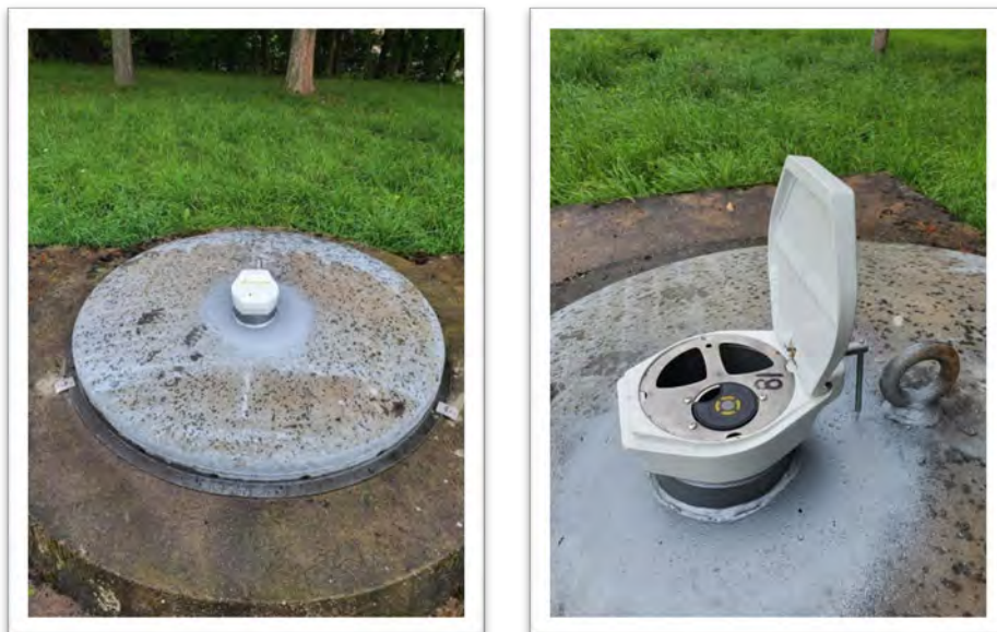
Etat avant et après travaux du point de Griesheim-Près-Molsheim
