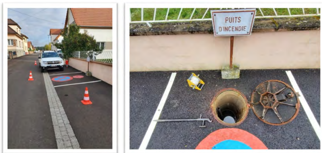
FIGURE 11 : BALISAGE AVEC CONES AUTOUR DU Puits A ROSSFELD
