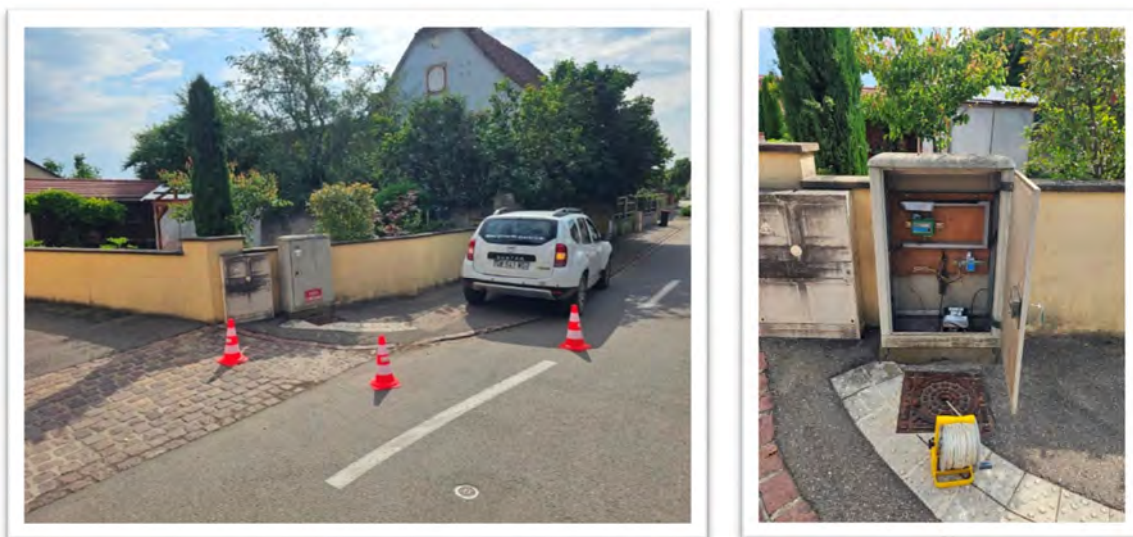
FIGURE 15 : ACCES BALISE ET SECURISE A LA CENTRALE NETDL 500 DU POINT RCS A HOLTZWIHR
