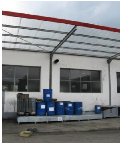
Déchets couverts et sur rétention
