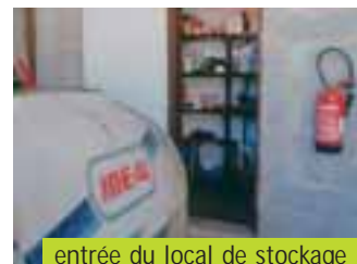
entrée du local de stockage (seuil de porte, extincteur)
