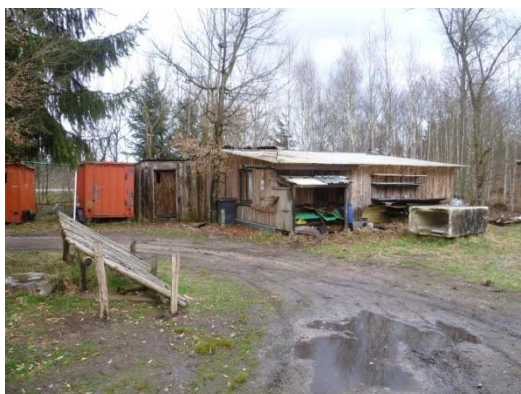
Construction (abris de chasseur) déjà implantés dans la clairière.
