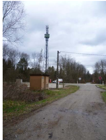
Chemin d'accès depuis la RD 1063 (environ 100m).
